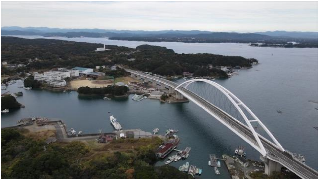
志摩和具浦に架かる志摩大橋(志摩パールブリッジ) (2020年12月9日)
