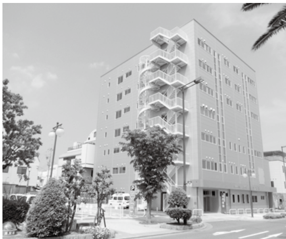
大門病院 外観
