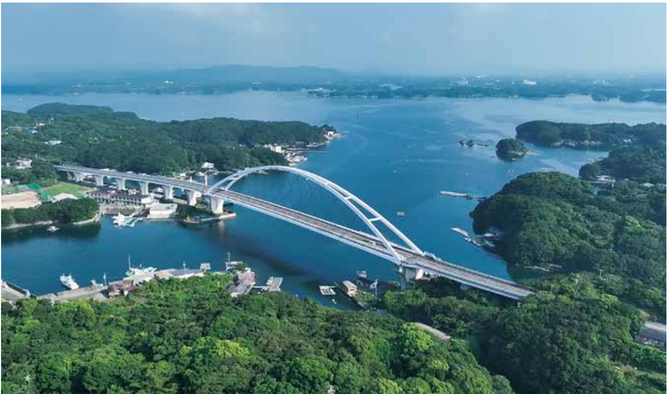
志摩大橋（志摩パールブリッジ）
