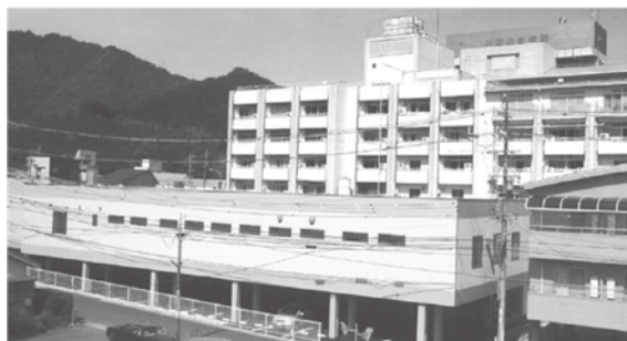
平成 1 9 年増築の透析センター
