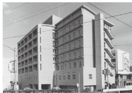
平成 8 年増築の新棟
